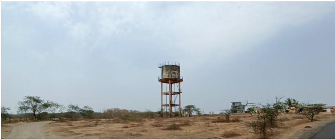
फोटो क्र. २१ गुळाणी पाणी पुरवठा टाकी
